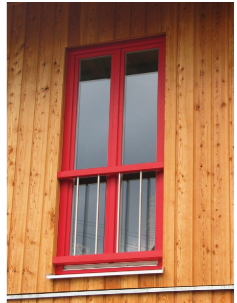
Es muss nicht immer Stahl oder Glas sein. Brüstungsgeländer im Dachgeschoß.
