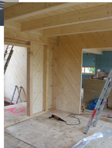
Ein Blick zurück in die Bauzeit: Eine Diagonalschalung aus Massivholz sorgt für die statische Aussteifung der innenwände
