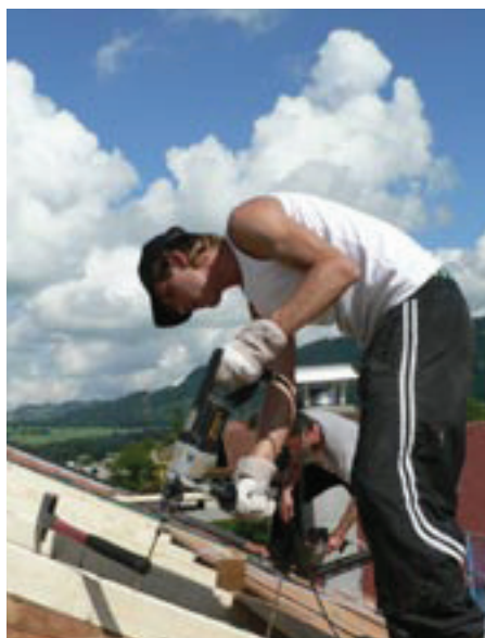
Für die Gaube muss der Sparrendachstuhl um 10cm aufgedoppelt und mit einer Pfette ergänzt werden. Die Mehrstärke ist gut für einen modernen Dämmstandard von 26cm und für hervorragenden sommerlichen Wärmeschutz.
