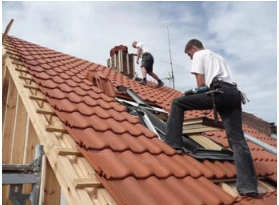
Nachdem das Dach von aussen geöffnet, gedämmt und dann wieder geschlossen wurde ist schnell wieder Wetterfestigkeit erreicht. Der Dachüberstand musste verlängert werden. Links im Bild an der Wand die Lattung für die Holzweichfaserdämmung unter der Fassade.
