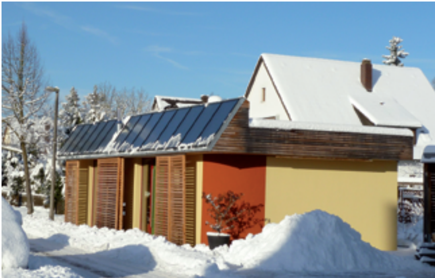
Die Solaranlage ist steil gestellt – für wenig Ertrag im Sommer und für mehr im Winter
