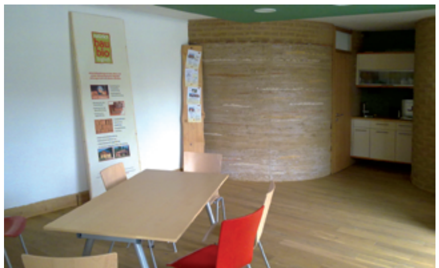
Die Stampflehmwand links verbirgt WC und Stuhllager, die Lehmstein-Mauer gegenüber den großen Solarspeicher
