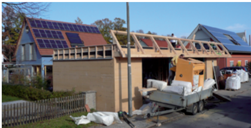
Einblasen der Holz-Lehm-Dämmung – hier kann der Bauherr helfen
