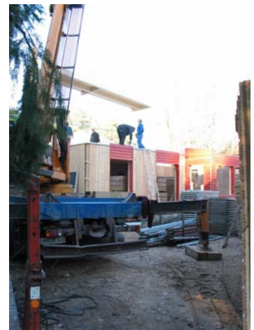
In 2 Tagen steht das ganze Haus
